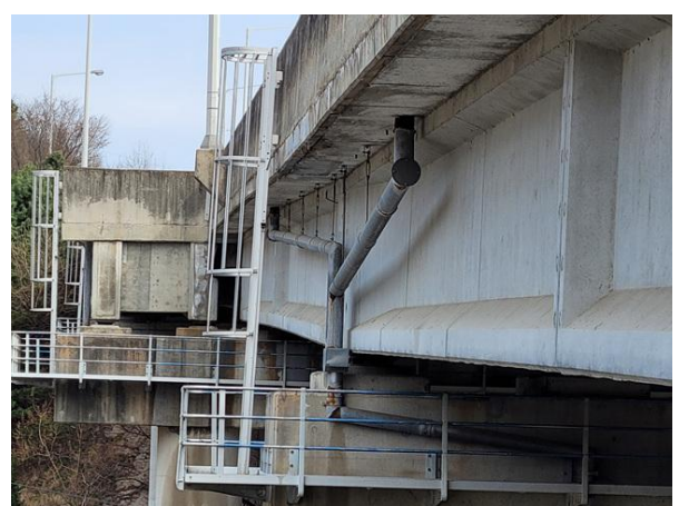
배수시설 배수관 전경
