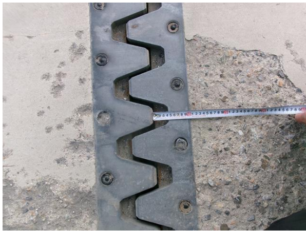
신축이음 유간 측정 작업사진
