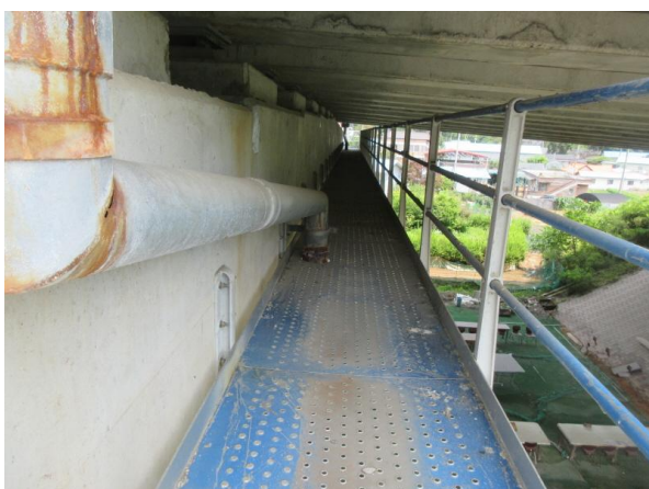
점검통로 상태양호 P3
