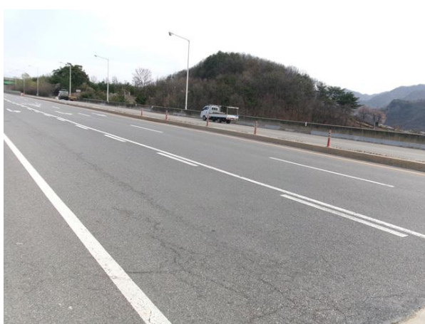
부대시설 가로등 전경
